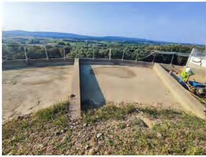
2023-06 Courmonterral Sainte Cécile avancée de l'étanchéité des toitures! Enlèvement des terres- nettoyage-isolation et étanchéité.
