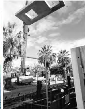
2023-11-07 Pose du regard de la vanne de régulation (vanne annulaire) pour le déploiement d'optim au niveau de Sète rue des chantiers.
