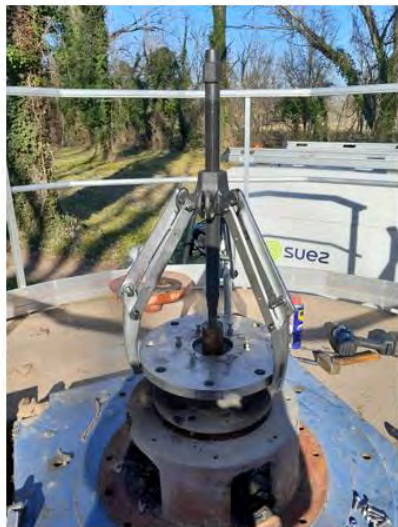
2023-03 Démontage d'une pompe à ligne d'ar bre sur l'usine de Florensac.
