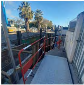
2023-11-07 Pose du regard de la vanne de régulation (vanne annulaire) pour le déploiement d'optim au niveau de Sète rue des chantiers.
